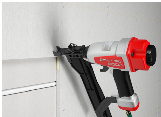
Application de plaques fibres-gypse en recouvrement des éléments chauffant
