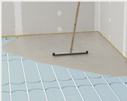
Recouvrement des éléments de plancher chauffant fermacell® Therm25™ par un enduit de ragréage
